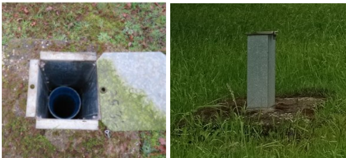
Figure 22 : Photographies du sondage 12S1
