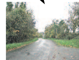
Tronçon ouest de la rue des Plages
