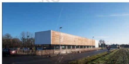
Une clôture en harmonie avec la façade du bâtiment et des parkings en retrait de la route. Entreprise Artefacto à Redon D. Gras, architecte. (Source photographique internet)
