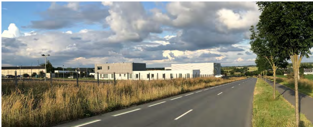
PARC D'ACTIVITES DE LA TOURELLE
