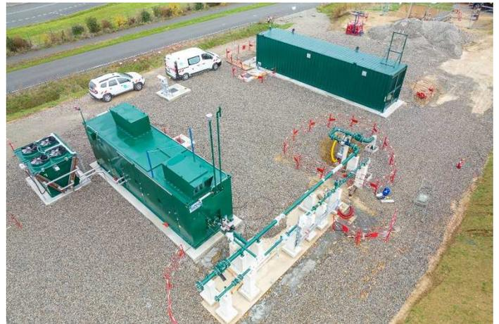
Cette infrastructure a pour objectif de comprimer et de faire remonter le gaz du réseau de distribution vers le réseau de transport. Le rebours sera donc utilisé quand la production locale de biométhane sera supérieure aux consommations sur le réseau de distribution.
